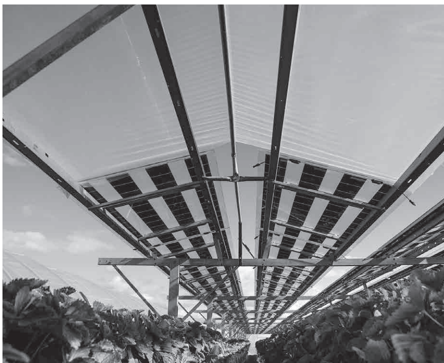
Bei Agri-PV sind die Module nicht deckend wie auf Gebäuden, denn die Nutzpflanzen benötigen Licht.
