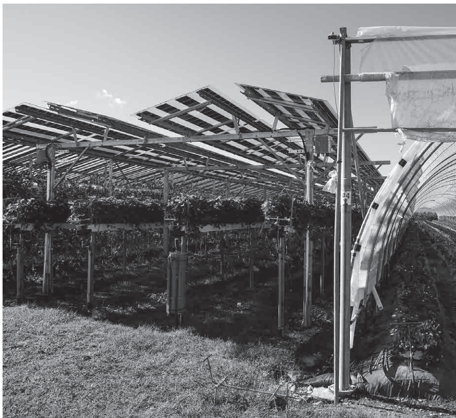
Les plantes cultivées ont besoin de lumière ; les modules PV conçus pour l'agrivoltaïsme ne sont donc pas totalement couvrants comme ils le sont sur les toitures des bâtiments.
